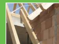
Dach- und Holzbau
