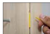
Haltefahne kann nach der Montage abgebrochen werden
