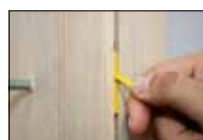
Genaueres Ausrichten durch Haltefahne
