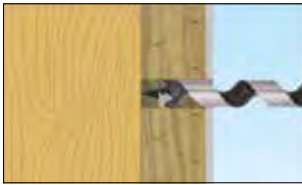
Bohrloch mit \varnothing 14 mm in der Dämmung erstellen. Bohrlochtiefe: 50 mm
