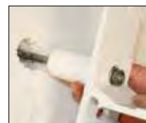
5. Bei Durchsteckmontage: Konsole mit RECA Dimos montieren.
