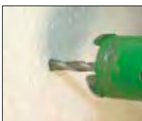
1. Loch in Isolierung bohren.
