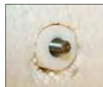
4. Bei Vorsteckmontage: Dübel vormontieren, RECA Dimos montieren.
