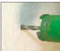
1. Loch in Isolierung bohren.
