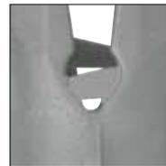
**Die Einschlagsicherung** verhindert die frühzeitige, ungewollte Spreizung des Dübels beim Einschlagen. Sie hält die Schraube zentrisch und verhindert das seitliche Ausbrechen.
