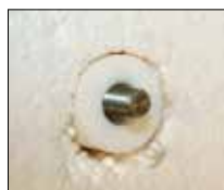
4. Bei Vorsteckmontage: Dübel vormontieren, RECA Dimos montieren.
