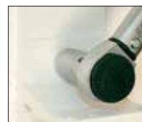
6. Konsole entsprechend den Montagevorschriften des verwendeten Dübels befestigen.
