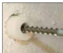
2. Loch in Untergrund bohren (evtl. RECA Dimos als Zentrierhilfe verwenden).
