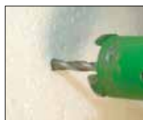
1. Loch in Isolierung bohren.
