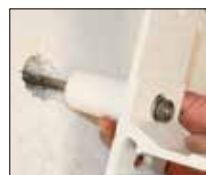
5. Bei Durchsteckmontage: Konsole mit RECA Dimos montieren.
